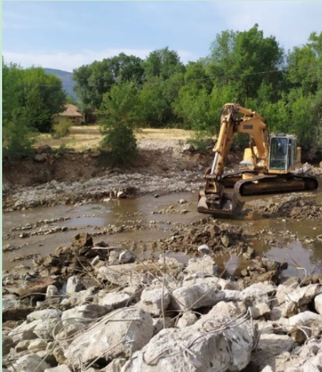
Travaux de démolition de la station de jaugeage
