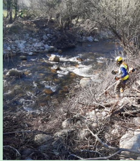
Travaux de débroussaillage dans la rivière Jerte après les inondations du mois de décembre 2019
