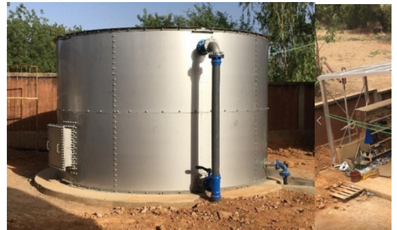
Installation d'un réservoir d'eau brute
