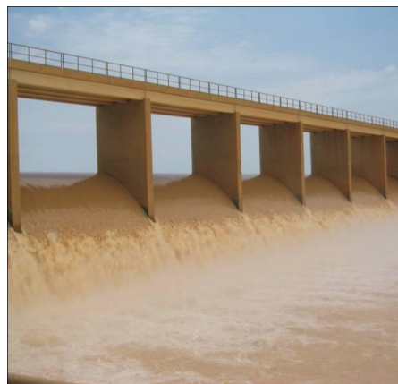
Vertedero - Presa de Ziga © Boureima Nebie
