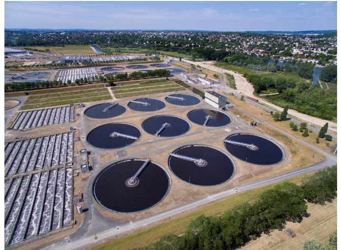
Figura 195. Vista de las plantas depuradoras de Seine Aval y Grésillons (fuente: SIAAP)
