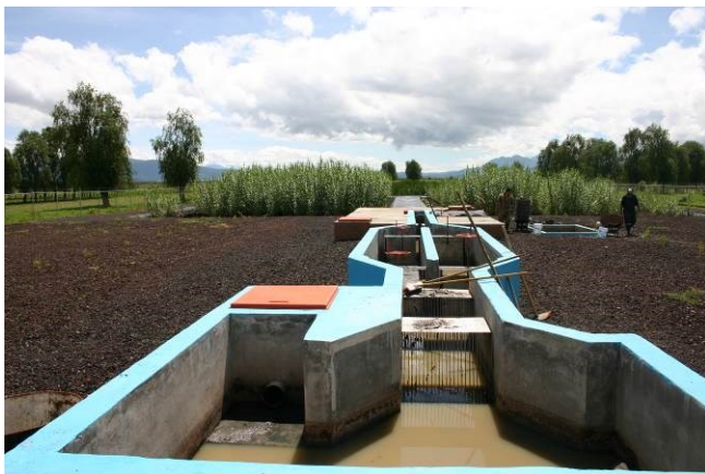
Figura 5. Humedal artificial de Erongarícuaro
