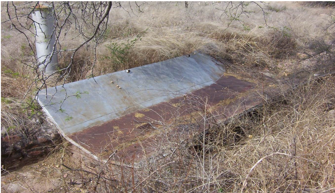
Figura 2.- Aforador para flujo supercrítico Santa Rita en el cauce a la salida de la cuenca La Cruz.
